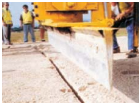
Fotografía 4. Sistema junta activa
