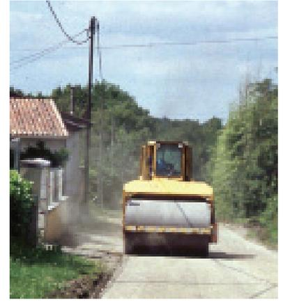
De izquierda a derecha: Extendido de un conglomerante hidráulico - Vista de una recicladora con dosificadora de lechada de cemento - Compactación de la capa con un rodillo vibrante.
