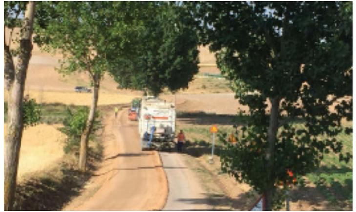
Reciclado del pavimento in situ con cemento.
