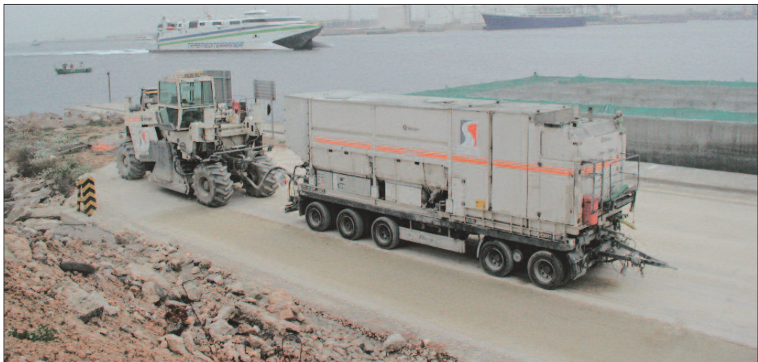
Figura 6.4 Estabilización de una plataforma portuaria
