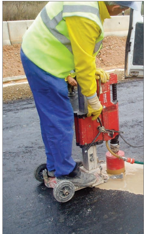
Figura 7.6 Extracción de testigo
