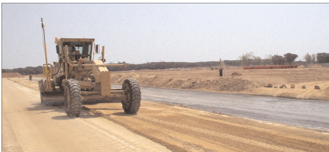
Figura 5.33 Motoniveladora guiada por sistema 3D
