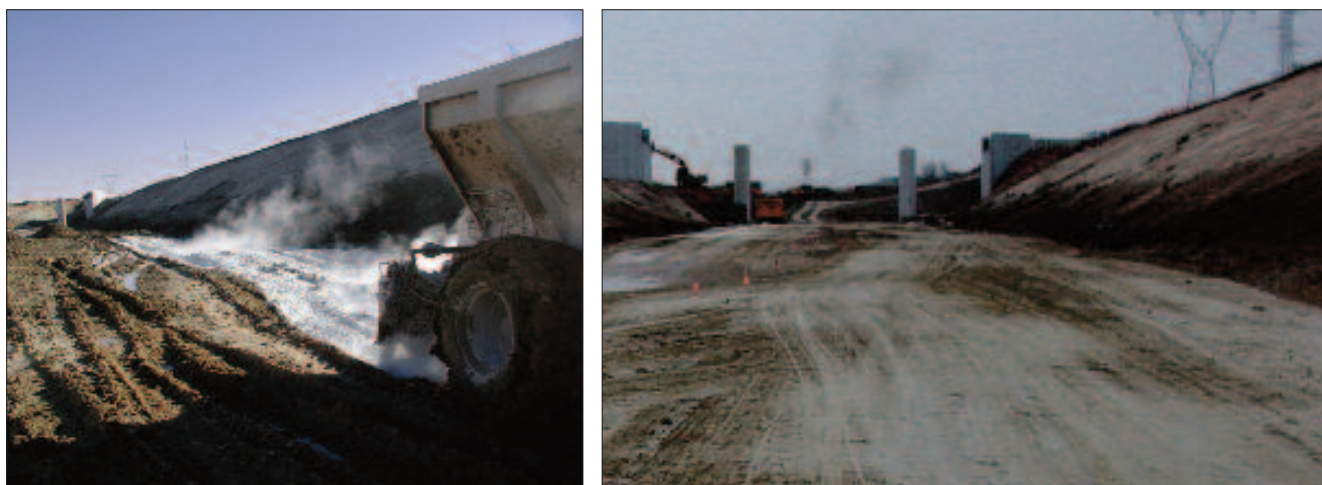
Figura 6.3 Secado de suelo húmedo con cal viva y plataforma terminada
