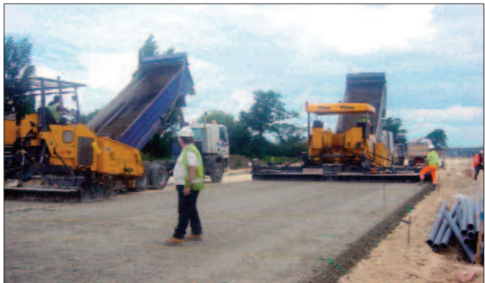
Figura 5.38 Transporte del material estabilizado en camiones basculantes y colocación con extendedoras en paralelo
