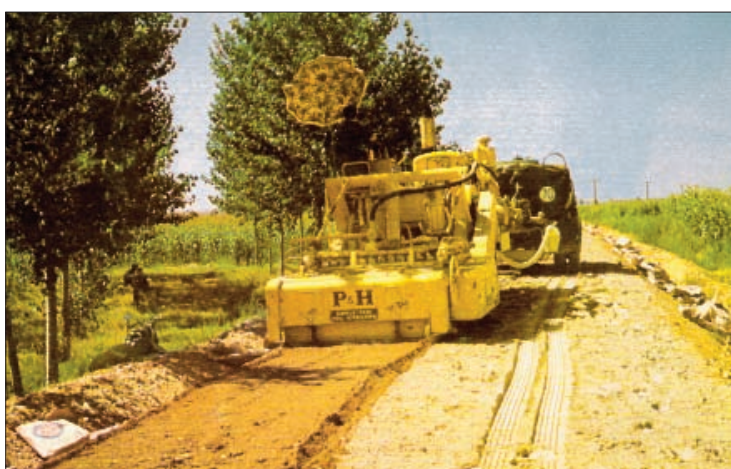
Figura 1.7 Camino agrícola de suelocemento ejecutado in situ por el Instituto Nacional de Colonización
