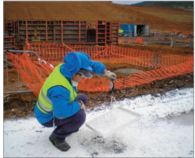
Figura 7.2 Bandeja para control de la dotación de conglomerante y pesado de la misma
