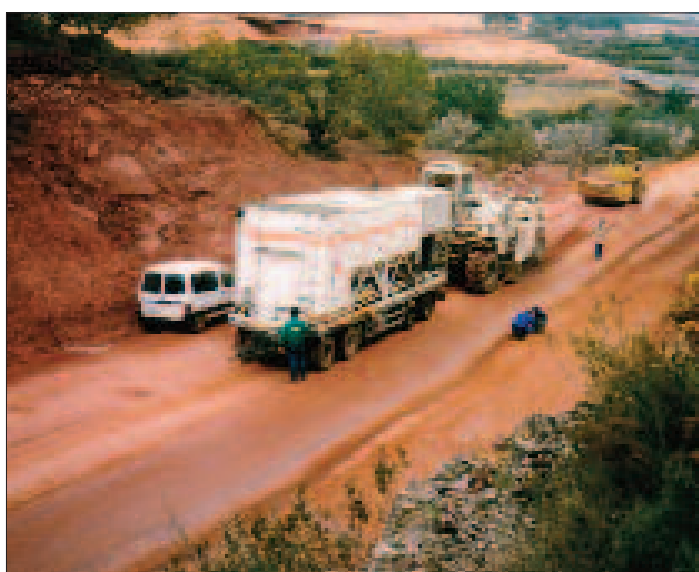
Figura 6.1 Estabilización por vía húmeda
