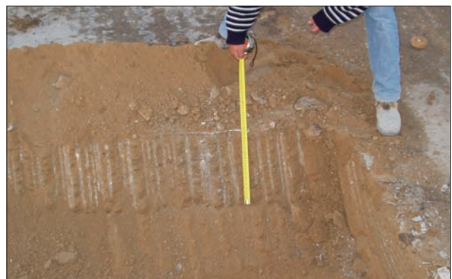
Figura 7.3 Control de espesor de capa estabilizada
