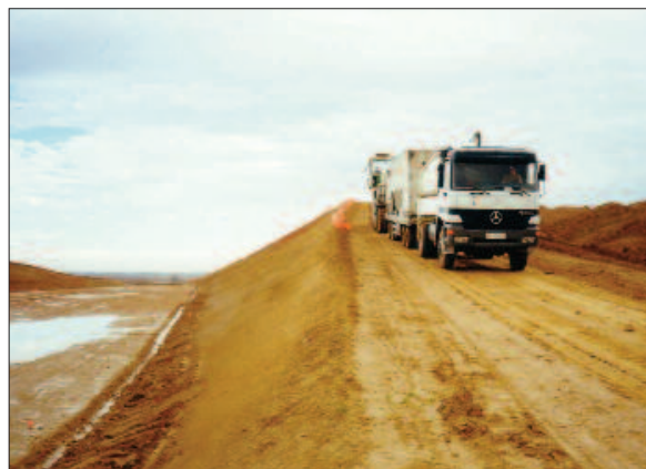
Figura 6.5 Estabilización de un terraplén
