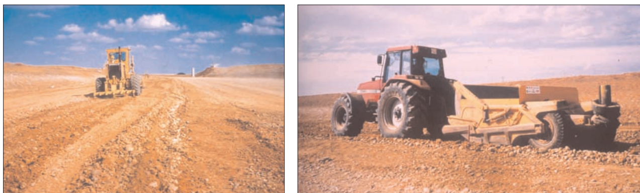
Figura 6.8 Preparación del suelo mediante ripado y retirada de elementos gruesos.
