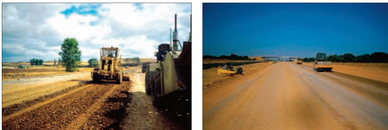
Figura 6.16 Refino del material con motoniveladora y compactación final
