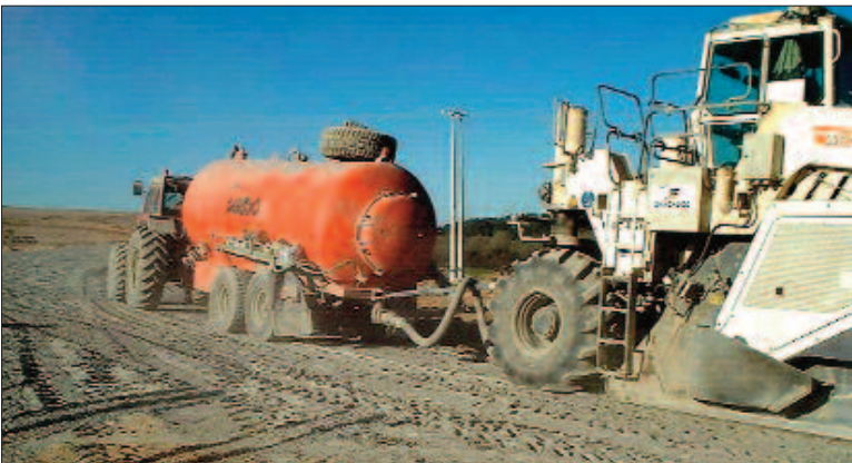
Figura 5.10 Cuba de agua acoplada a la estabilizadora en trabajo por vía seca
