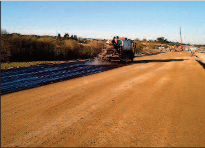
Figura 5.35 Riego de curado con emulsión
