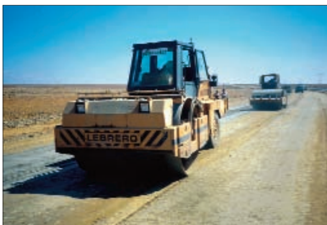
Figura 6.14 Rodillos vibratorios compactando capas estabilizadas
