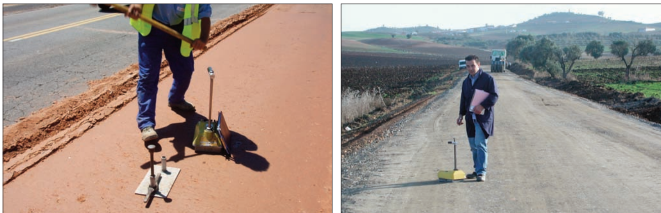
Figura 7.4 Control de densidad con sonda nuclear
