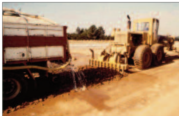
Figura 5.8 Escarificación del suelo con ripper de niveladora para facilitar su humectación
