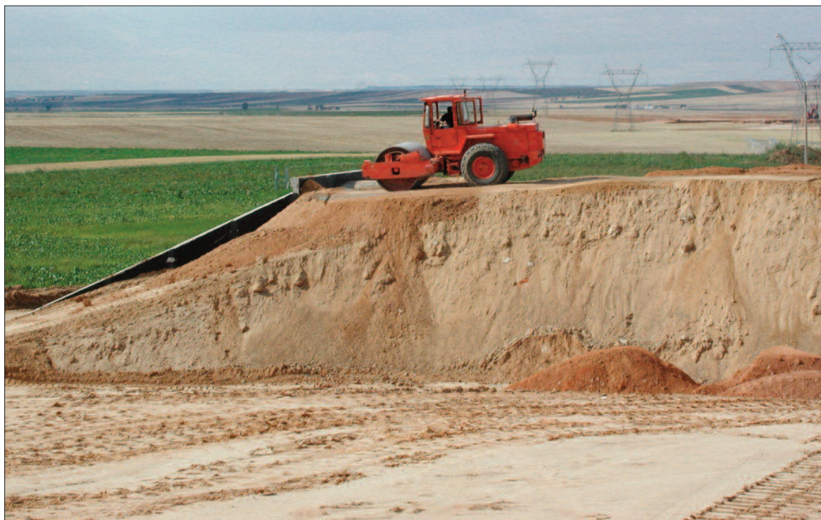
Figura 6.7 Compactación de terraplén
