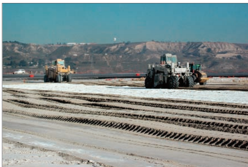
Figura 1.1 Estabilización con cal
