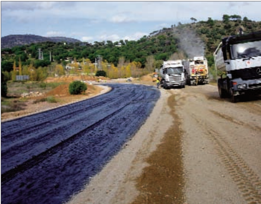
Figura 2.6 Suelo estabilizado protegido con emulsión y sin ella
