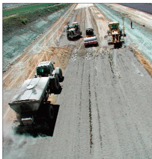
Figura 1.2 Estabilización con cemento
