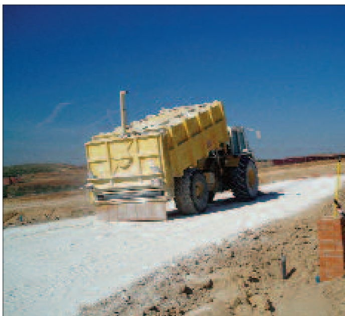
Figura 6.2 Distribución de conglomerante por vía seca
