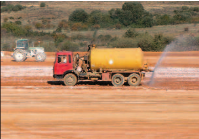
Figura 5.9 Humectación con cisterna
