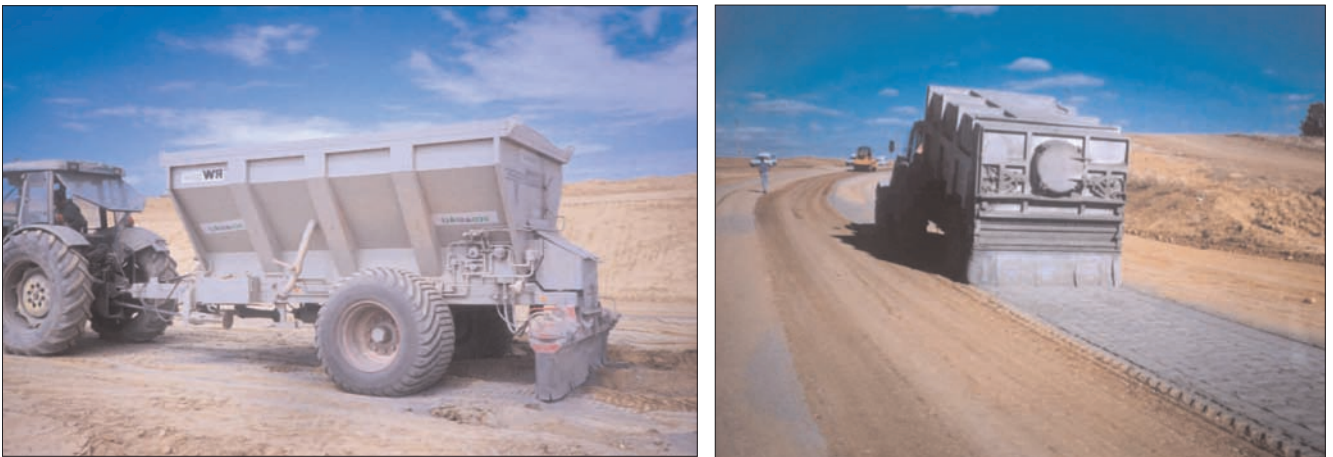
Figura 6.10 Distribución del conglomerante en polvo (vía seca)
