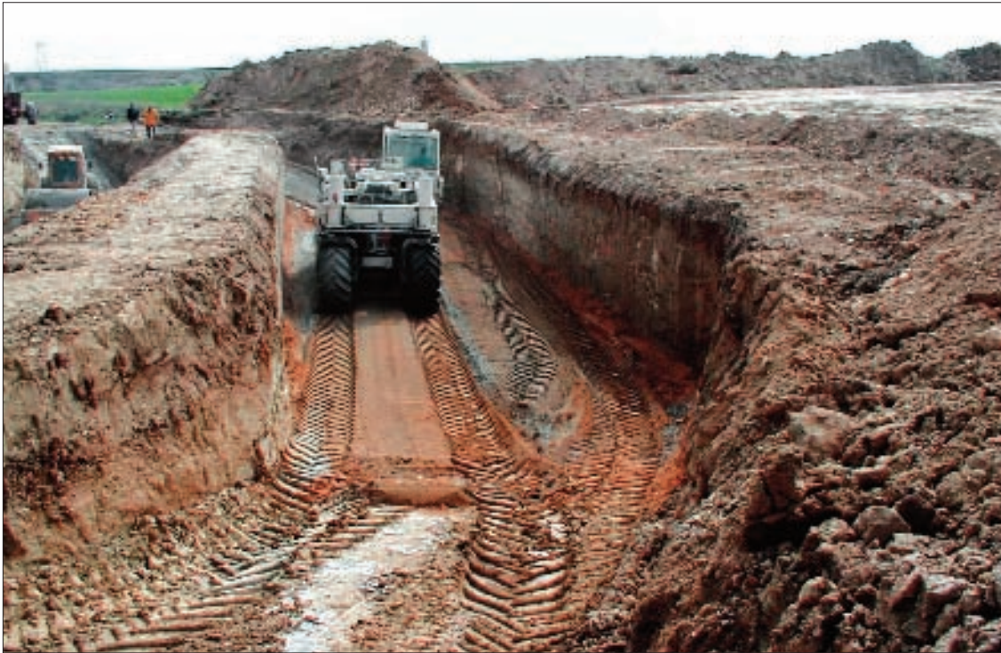
Figura 1. 5 Estabilización de la cimentación de una estructura
