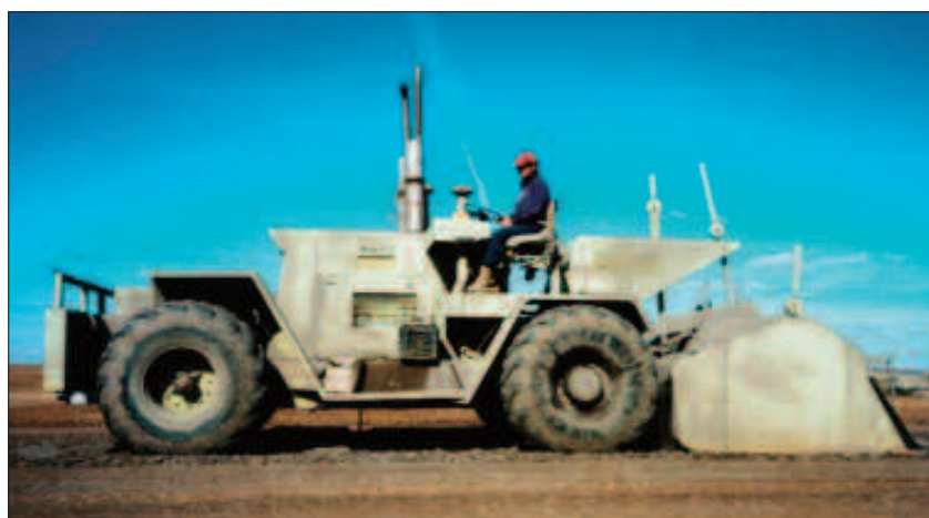
Figura 5.17 Estabilizadora tipo pulvimezclador
