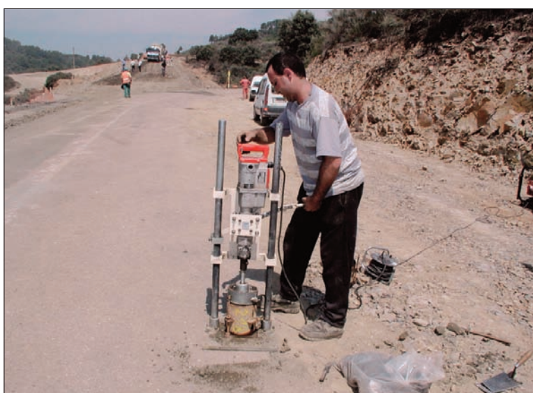
Figura 7.5 Fabricación de probeta en obra con martillo vibrante
