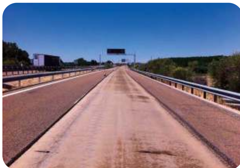
Figura 8.10.- Marcas dejadas por la emulsión de la prefisuración de juntas tras terminar el reciclado
