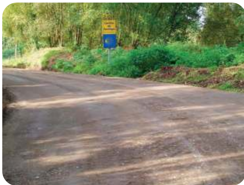
Figura 2.1.- Reciclado de la carretera "Camino de Santiago Asturiano"
