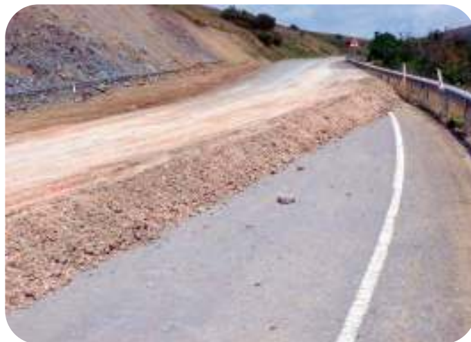
Figura 8.15.- Compatibilidad del reciclado con correcciones puntuales de trazado y peraltes
