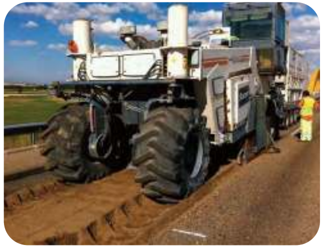
Figura A5.12. y A5.13. Autovía A-231 o Camino de Santiago. Reciclado con cemento del carril lento para rehabilitar varios tramos en las provincias de León y Palencia..
