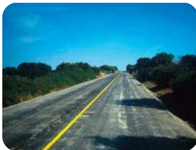
Figuras 8.32 y 8.33.- Terminación final del reciclado antes de extender la capa bituminosa de rodadura en diferentes carreteras
