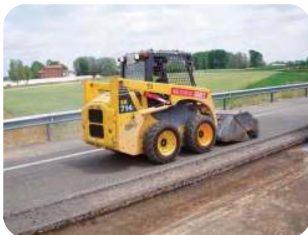
Figura 8.47.- Limpieza de la carretera para asegurar la adherencia
