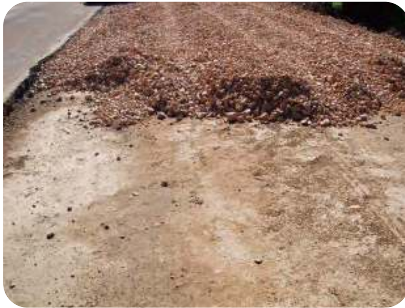
Figura 2.8.- En la caja del ensanche se dispone un material de características similares al del firme para reciclar todo junto (en la foto una zahorra artificial).
