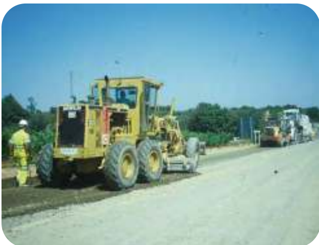
Figura A5.10.- Refino con motoniveladora. Barcelona. 2001
