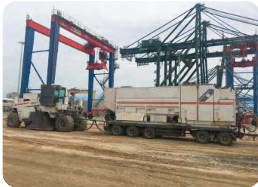
Figura 1.7.- Reciclado de una superficie en un puerto
