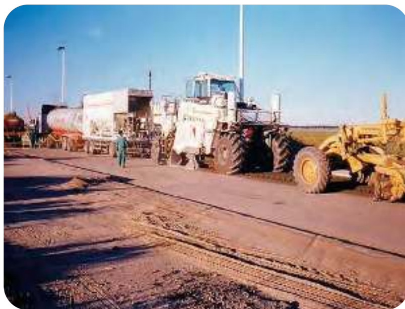
Figura 1.21.- Reciclado con cemento y emulsión
