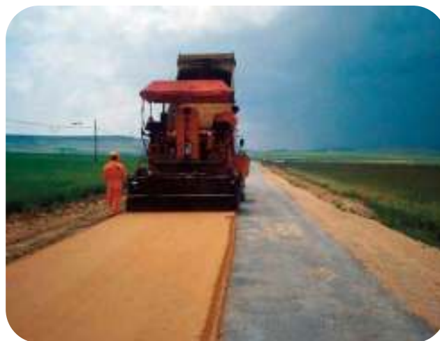
Figura A5.5.- Extensión del corrector granulométrico. Sacramenia. Segovia. 1998
