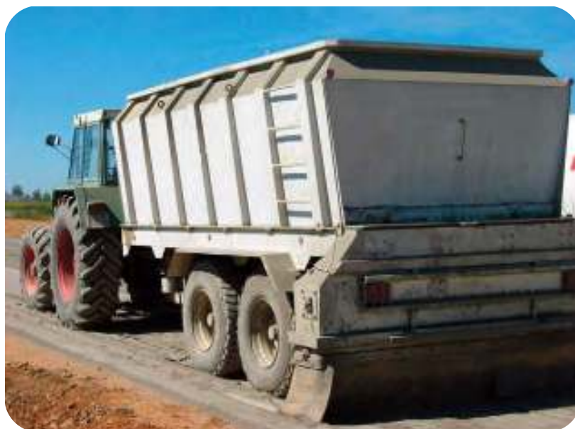
Figura 8.6.- Extendido del cemento en polvo
