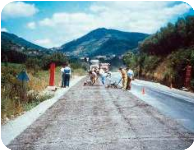
Figura A5.8.- Prefisuración en la Ruta de la Plata. 1995
