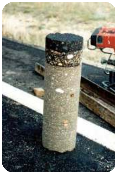
Figura 9.10.- Testigos extraídos de una capa reciclada
