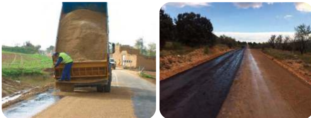
Figuras 8.26 y 8.27.- Protección superficial del reciclado con gravilla y compactación posterior
