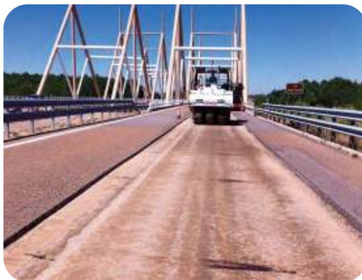
Figura 7.24.- Rodillo de neumáticos utilizado para cerrar la superficie en la reparación de una autovía
