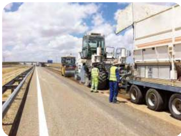
Figura 10.6.- Equipo de reciclado en una autopista
