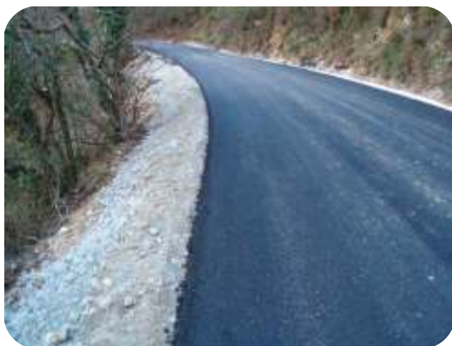
Figuras 8.32 y 8.33.- Terminación final del reciclado antes de extender la capa bituminosa de rodadura en diferentes carreteras
