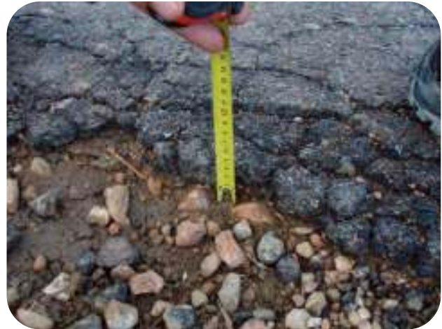
Figuras 1.14 y 1.15.- Reciclado de una capa (suelo seleccionado) y 2 capas de materiales (zahorra y riegos)
