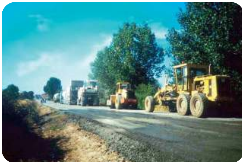
Figura 8.4.- Equipos para el reciclado con cemento de la carretera
