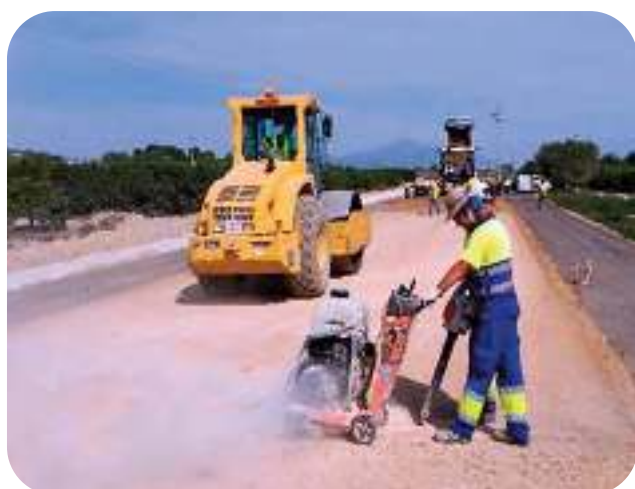
Figura A3.14 y A3.15. – Ejecución de la prefisuración mediante serrado en fresco.
