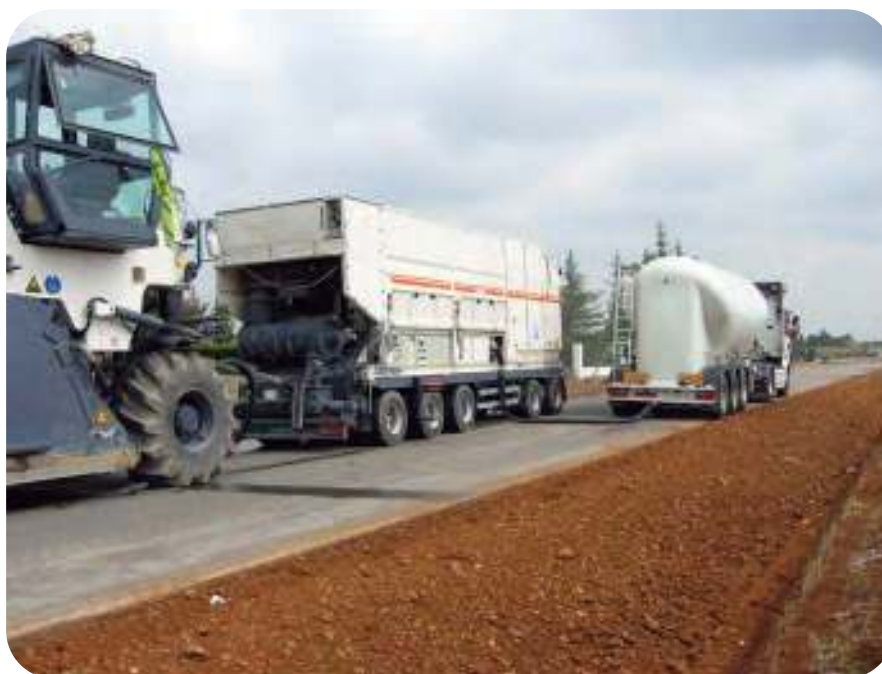
Figura 1.22.- Carga del cemento en la dosificadora de lechada para un reciclado
