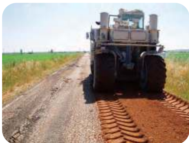
Figuras 1.1 y 1.2.- Reciclado de carreteras fisuradas y deterioradas
