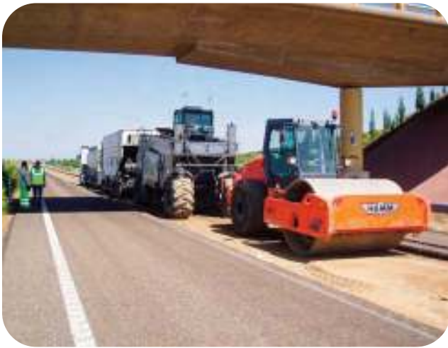
Figura A5.12. y A5.13. Autovía A-231 o Camino de Santiago. Reciclado con cemento del carril lento para rehabilitar varios tramos en las provincias de León y Palencia..
