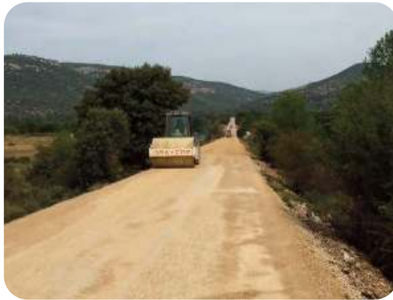
Figura 2.7.- Superficie una vez reciclada
