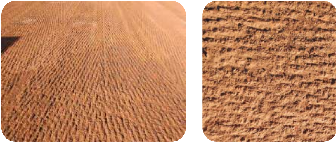
Figura A3.20 y A3.21. – Detalle del fresado de una capa de material tratado con cemento
