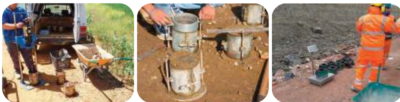
Figura 9.4 a 9.6.- Tamices y realización de probetas durante la realización de las obras
