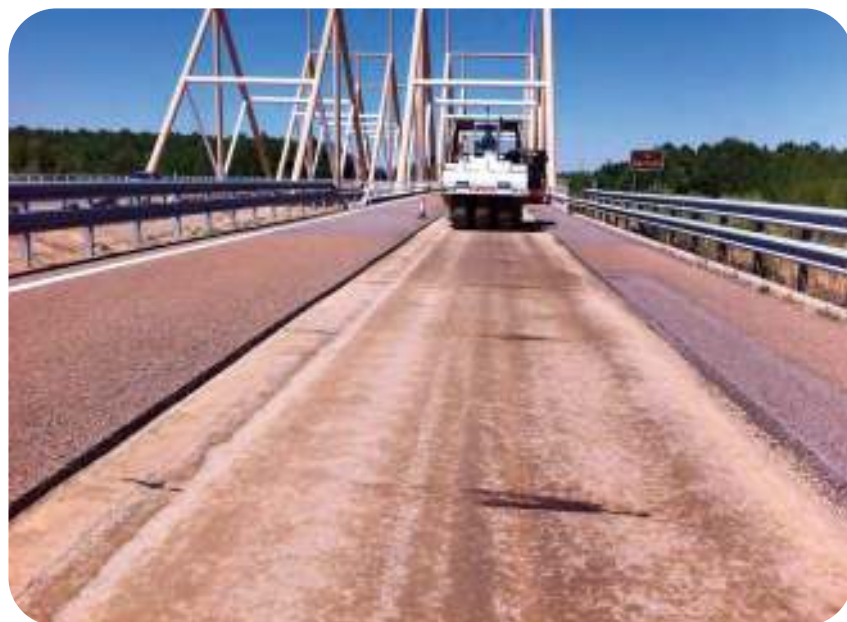
Figura A3.18 – Compactación final sobre las juntas prefisuradas
