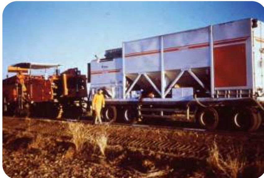
Figura 8.7.- Extendido del cemento en lechada
