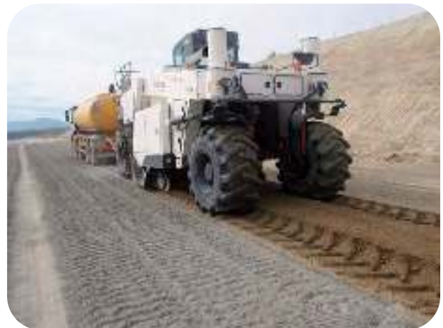
Figura 1.18.- Reciclado in situ con HRB E4
