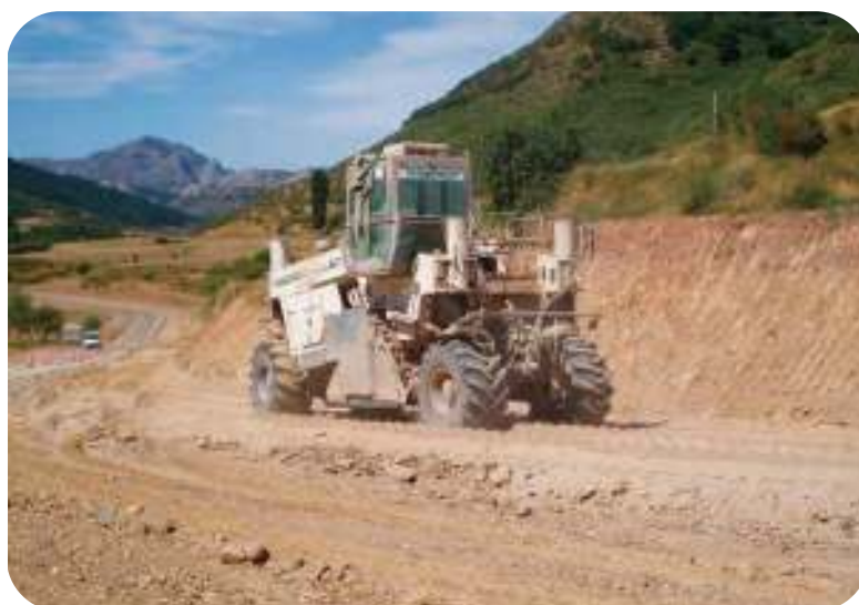
Figura 8.9.- Recicladora en un tramo en variante
