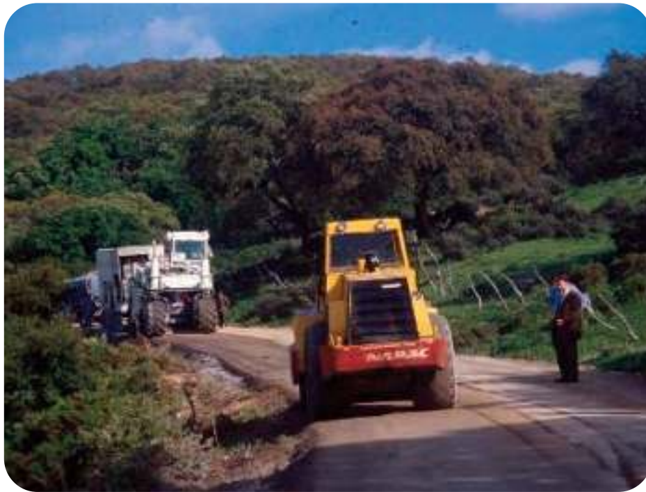
Figura 1.23.- Reciclado de una carretera
