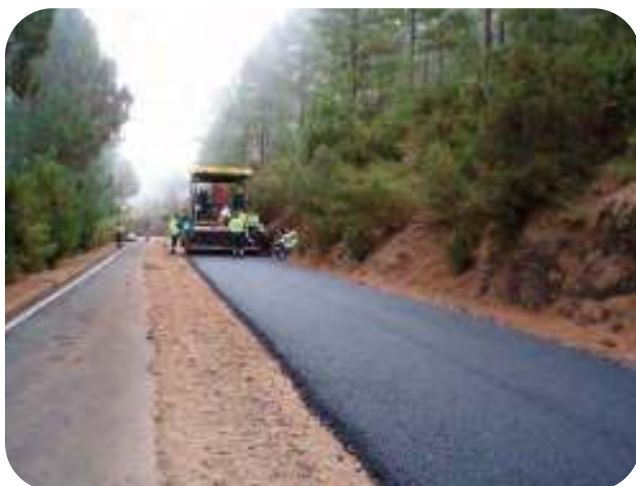
Figuras 8.34 y 8.35.- Diferentes tipos de carretera tras extender la capa bituminosa de rodadura
