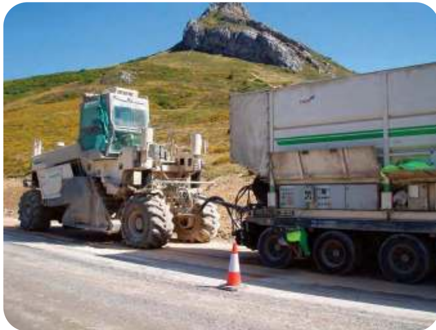
Figura 1.24.- Compactación tras el reciclado de una carretera local
