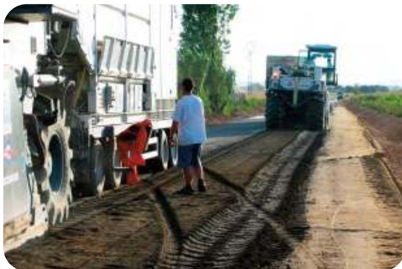
Figura 8.5.- Doble equipo de reciclado en una obra
