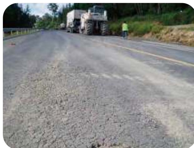
Figuras 1.1 y 1.2.- Reciclado de carreteras fisuradas y deterioradas
