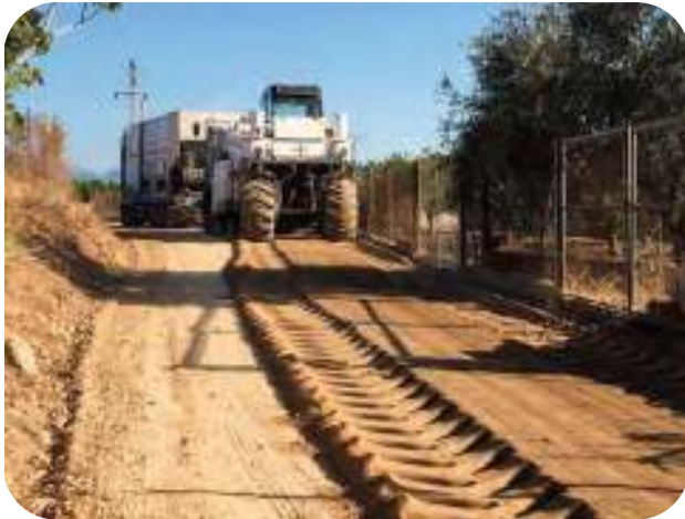
Figuras 1.14 y 1.15.- Reciclado de una capa (suelo seleccionado) y 2 capas de materiales (zahorra y riegos)
