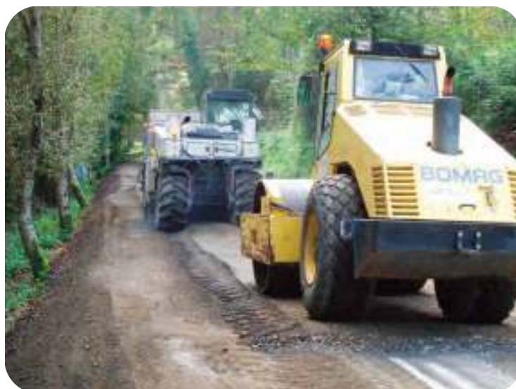
Figura 10.5.- Rodillo detrás de un equipo de reciclado in situ con cemento
