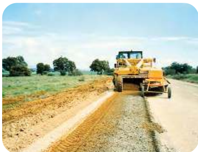
Figura A5.6.- Reciclado de arcenes en N-430. Badajoz. 1998
