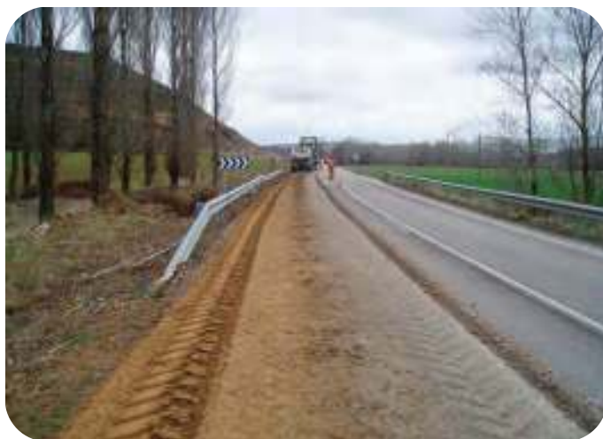
Figuras 8.16.- Reciclado de una banda
