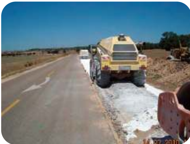
Figura 1.17.- Reciclado in situ con cal y cemento
