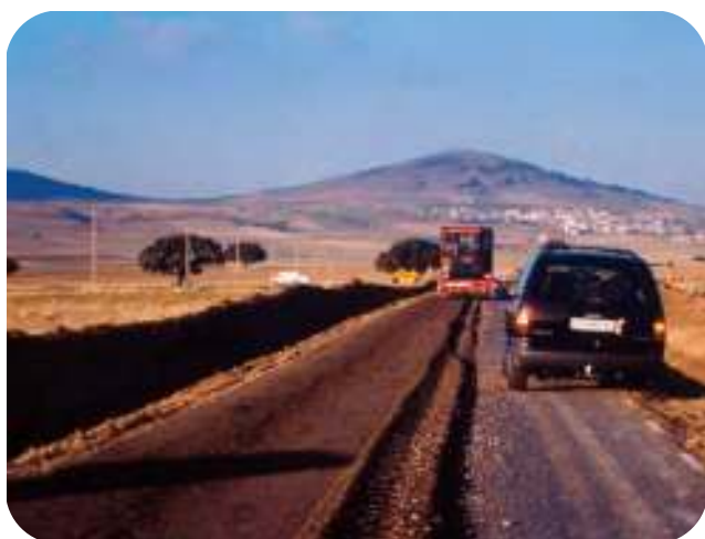
Figuras 8.24 y 8.25.- Reciclados de ancho variable con paso del tráfico
