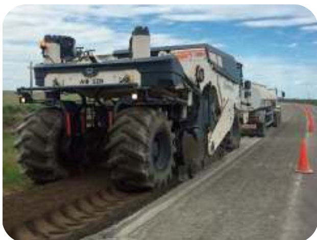
Figuras 1.12 y 1.13.- Reciclado en frío y en caliente
