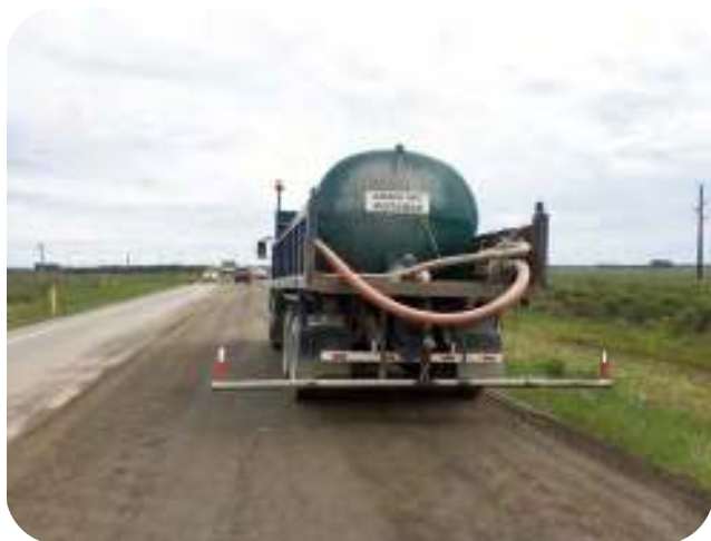
Figuras 8.43. y 8.44.- Curado con riego previo con agua y lanza de emulsión de una superficie pequeña
