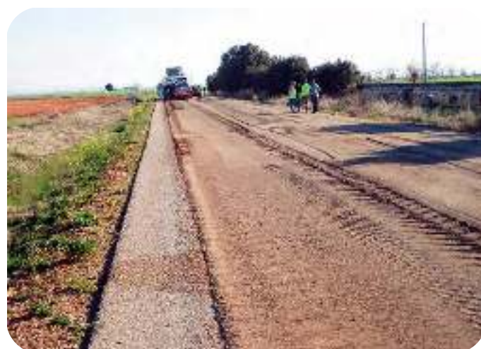
Figuras 8.17.- Reciclado respetando el arcén
