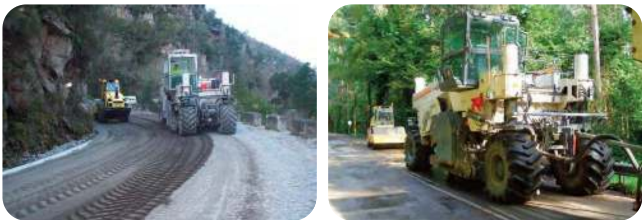
Figura 5.5 y 5. 6.- Reciclado de dos carreteras
