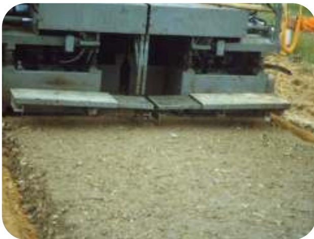
Figuras 1.10 y 1.11.- Reciclado in situ y en planta
