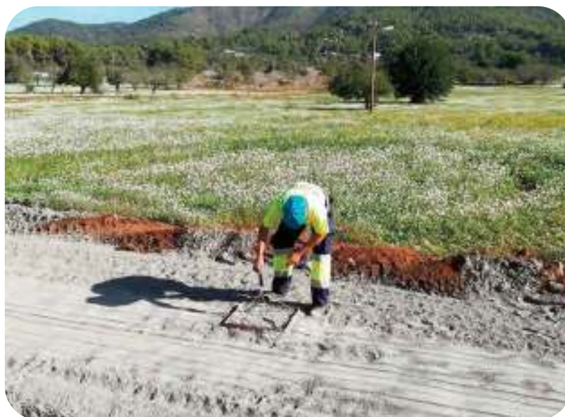
Figura 9.1.- Comprobación de la dotación de cemento
