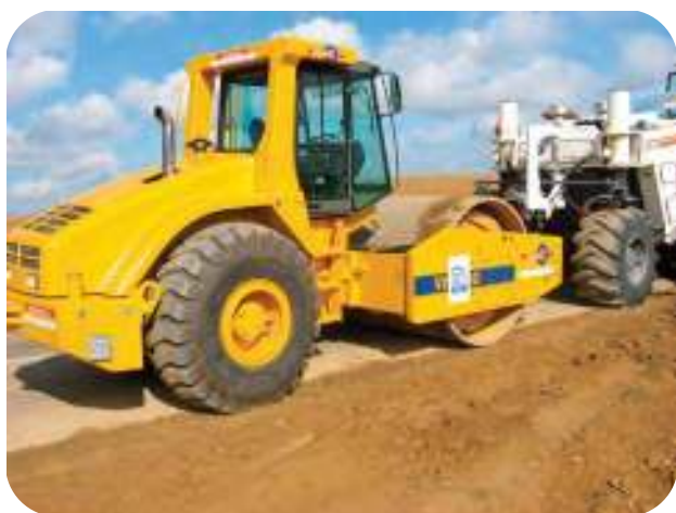
Figuras 1.8 y 1.9.- Compactación del material reciclado
