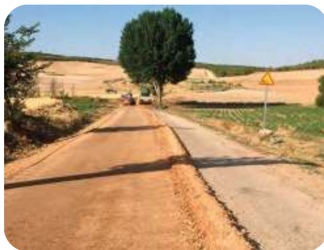
Figuras 8.28 y 8.29.- Reciclado con cemento en una carretera local y en un camino
