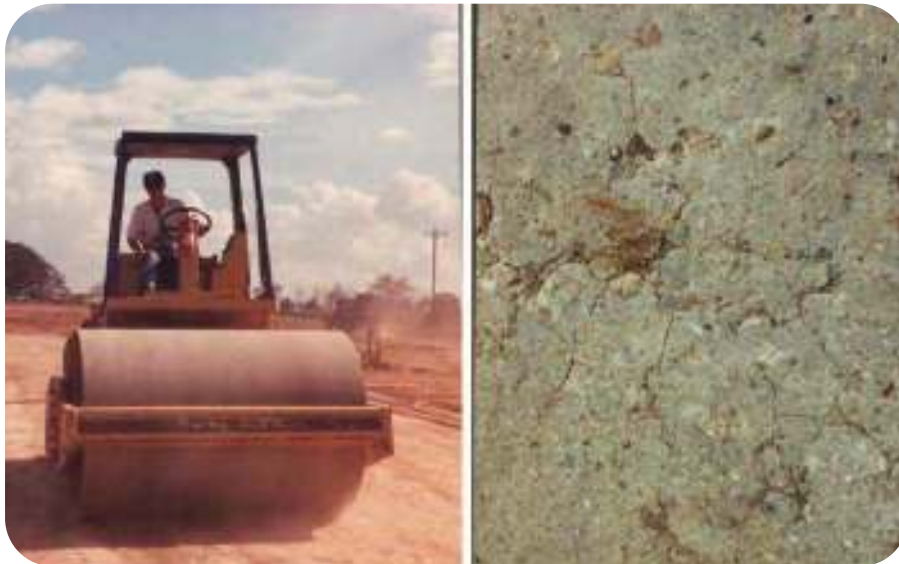
Figura A3.16 y A3.17. – Ejecución de la fisuración por aplicación de cargas pesadas
