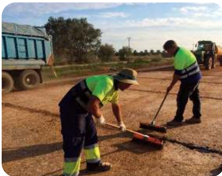
Figura A3.19 – Aplicación de un rastrillo sobre la junta prefisurada
