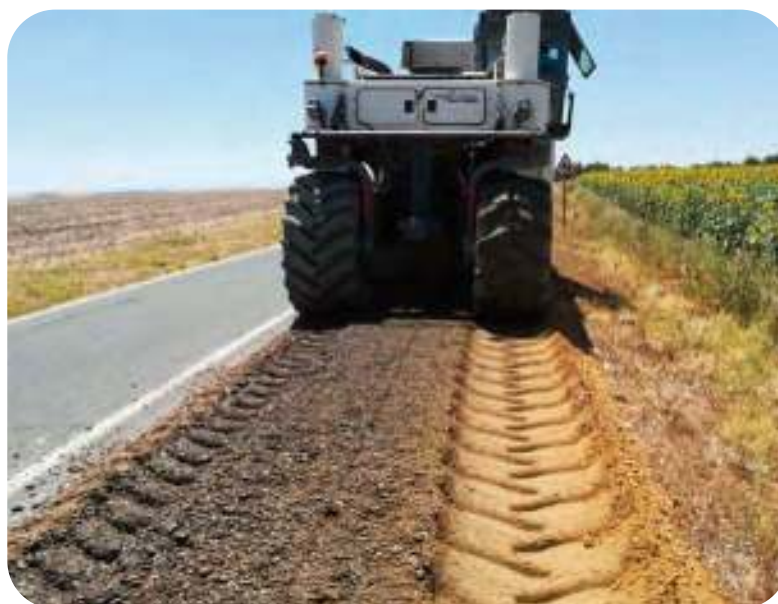
Figura A5.3. Reciclado de una carretera ensanchada
