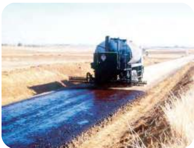
Figuras 8.22 y 8.23.- Curado con emulsión bituminosa
