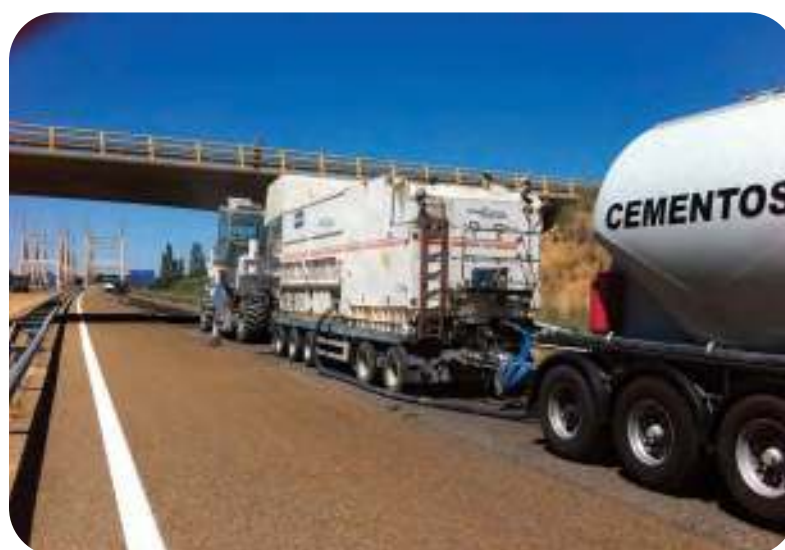
Figura 7.9.- Carga de cemento en la dosificadora de lechada
