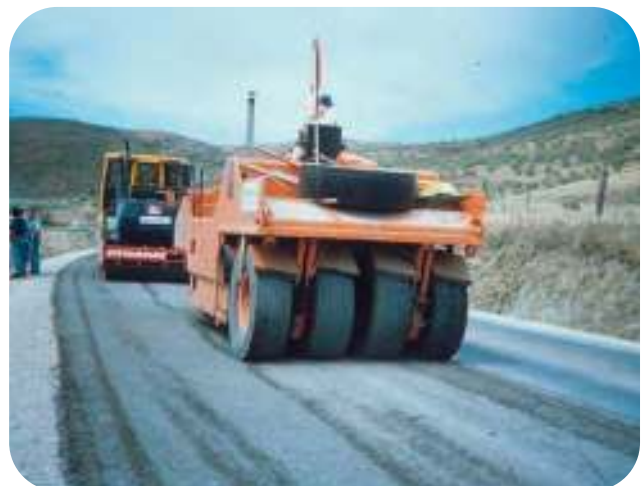
Figura A5.11.- Terminación con compactador de neumáticos. Cáceres. 1995
