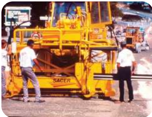
Figura A3.12 y A3.13 – Colocación y detalle de la Junta Activa*
