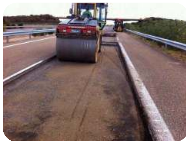
Figuras 1.8 y 1.9.- Compactación del material reciclado
