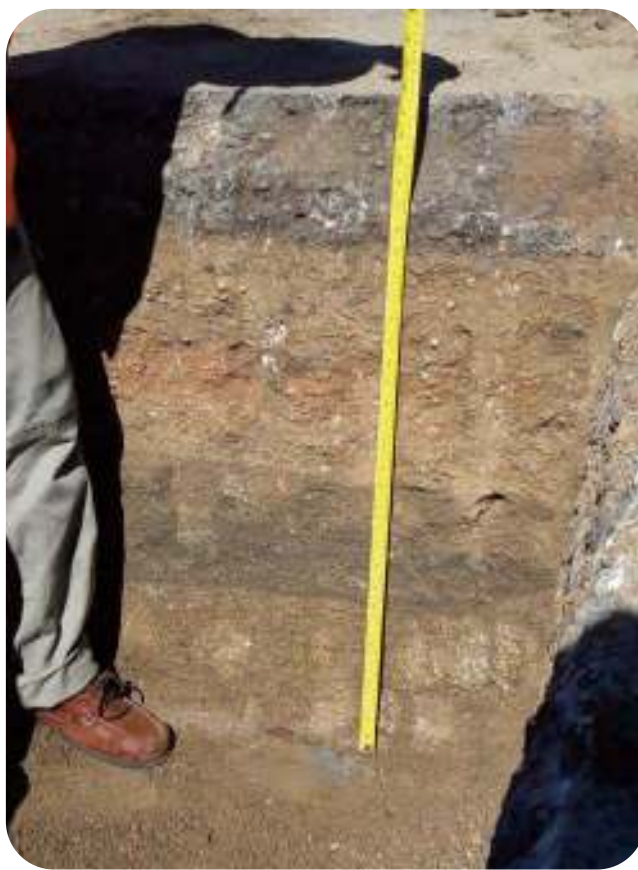
Figura 2.3.- Diferentes capas de una carretera
