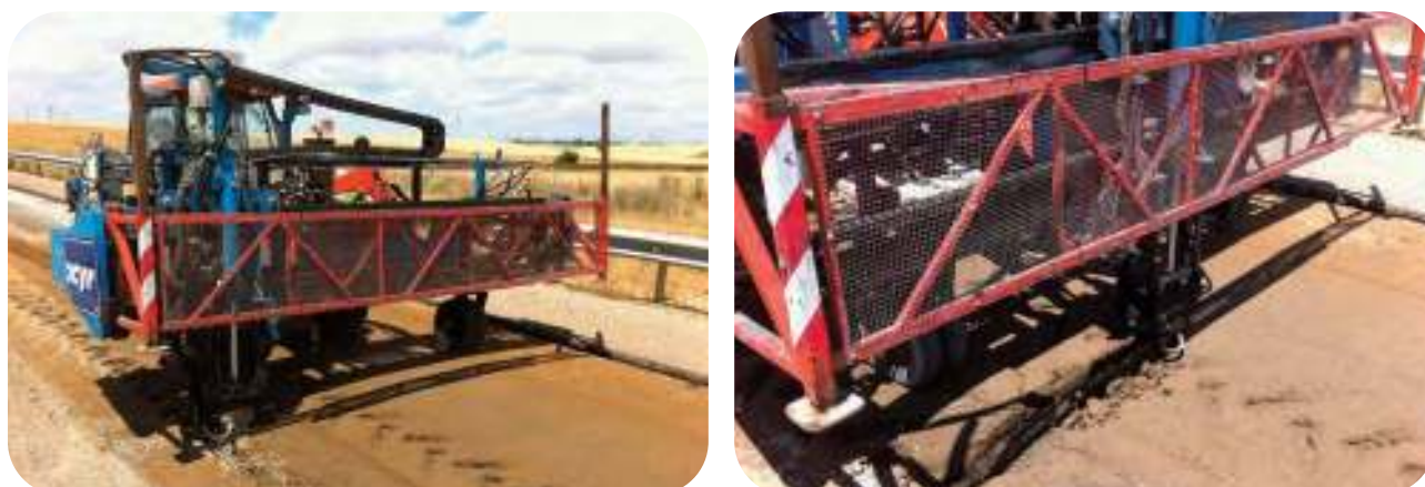
Figura A3.3 y A.3.4. – Vista general y detalle de corte con el sistema de celosía bastidor®
