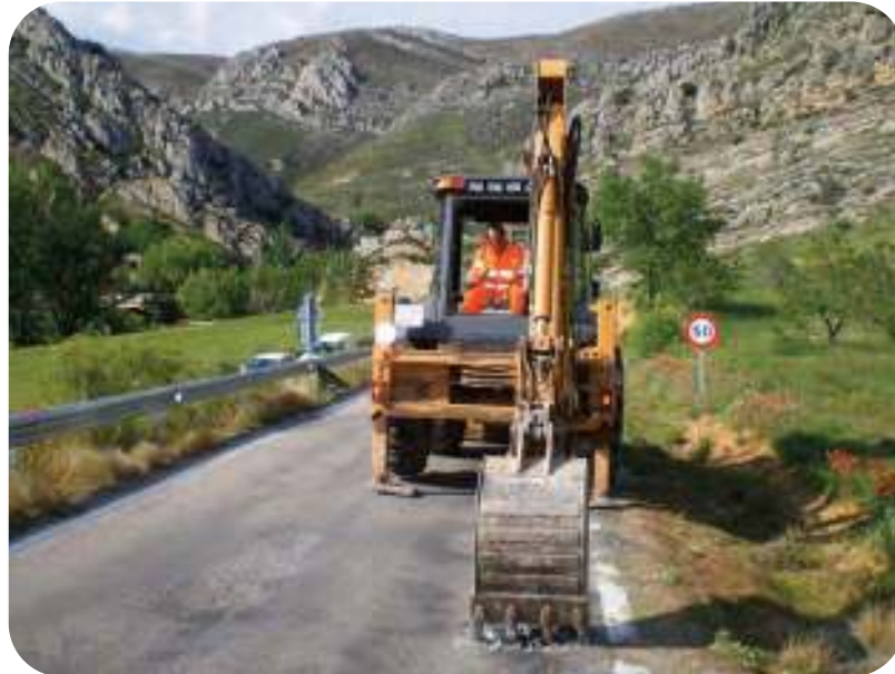
Figura 2.2.- Análisis de la naturaleza y espesores de las capas del firme.
