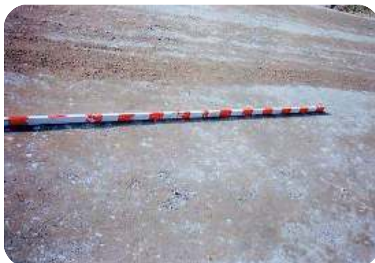
Figura 9.11.- Sencilla nivelación visual durante el reciclado
