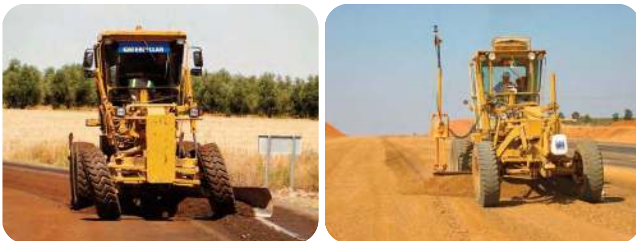
Figuras 8.13. y 8.14.- Refino y nivelación con motoniveladora
