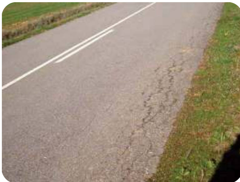
Figura 8.39.- No se deben reciclar los bordes si no se limpian previamente de materia orgánica y se confirma que hay el mismo material que en la carretera
