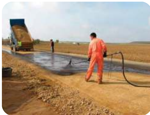
Figuras 8.43. y 8.44.- Curado con riego previo con agua y lanza de emulsión de una superficie pequeña
