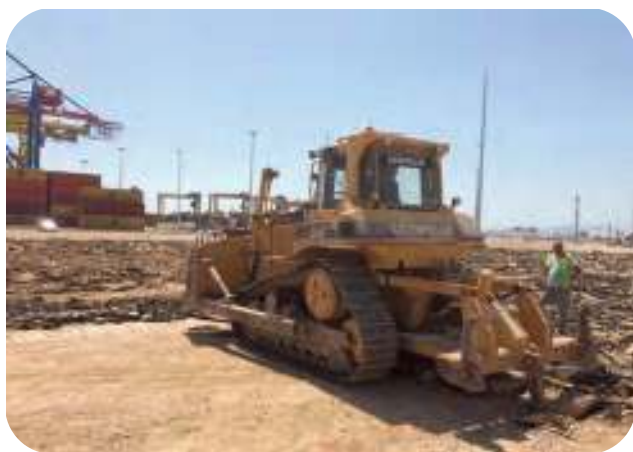
Figuras 8.1. y 8.2.- Preparación de la superficie existente antes del reciclado
