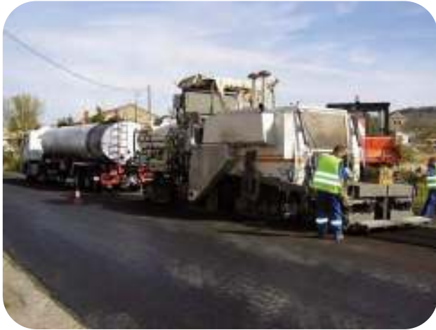
Figura 1.19.- Reciclado con emulsión bituminosa
