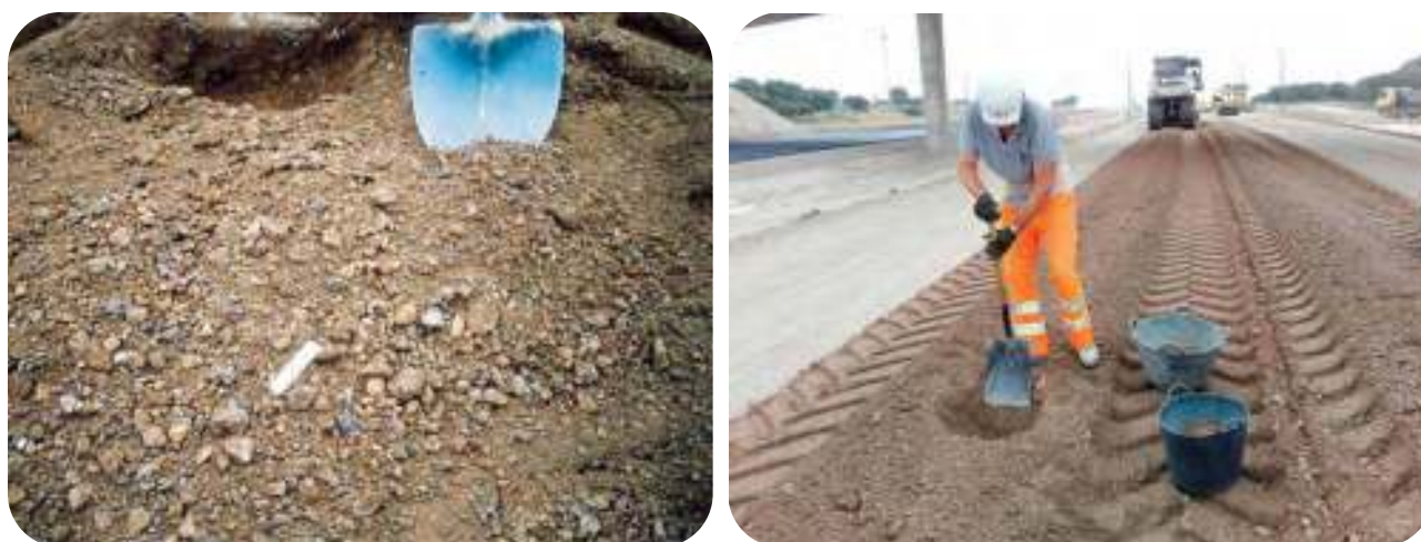
Figuras 9.2. y 9.3.- Apertura de calicatas y toma de muestras
