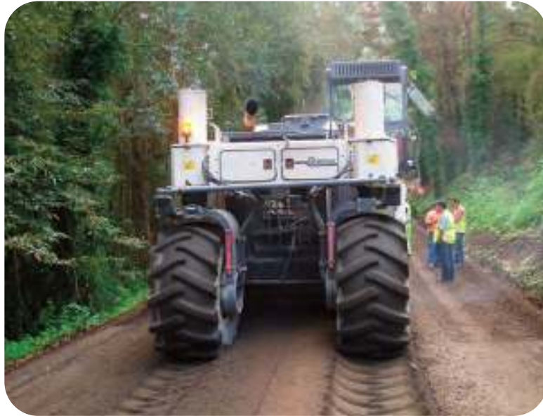
Figura 8.3.- Recicladora en una obra
