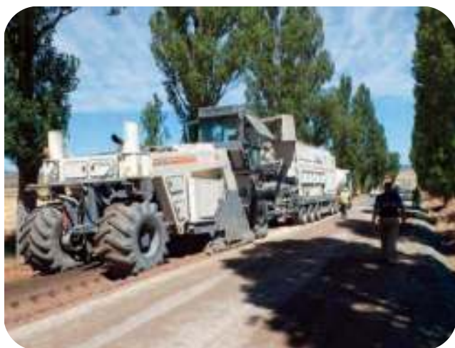
Figuras 8.28 y 8.29.- Reciclado con cemento en una carretera local y en un camino
