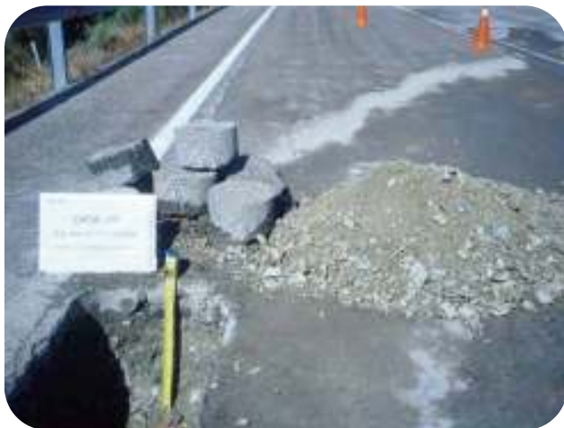
Figuras 2.4 y 2.5.- Calicatas y testigos de carretera a reciclar
