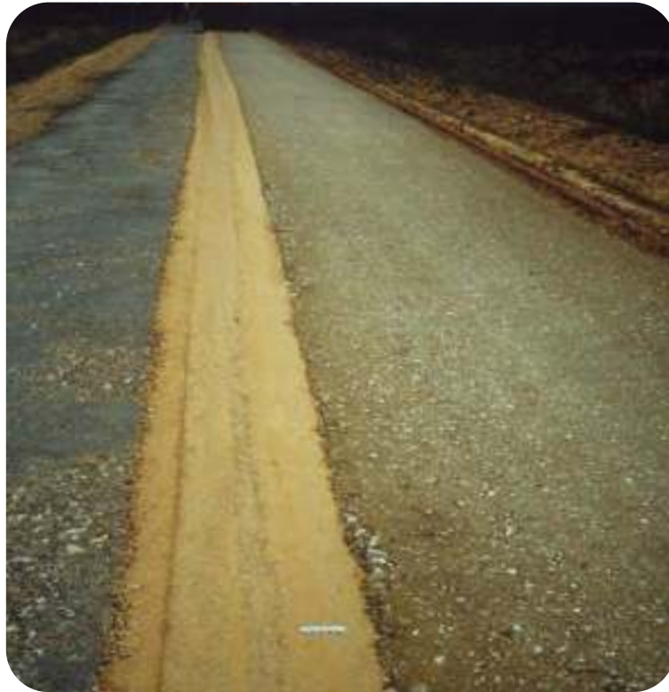
Figura 2.6.- Material reciclado con corrector granulométrico añadido
