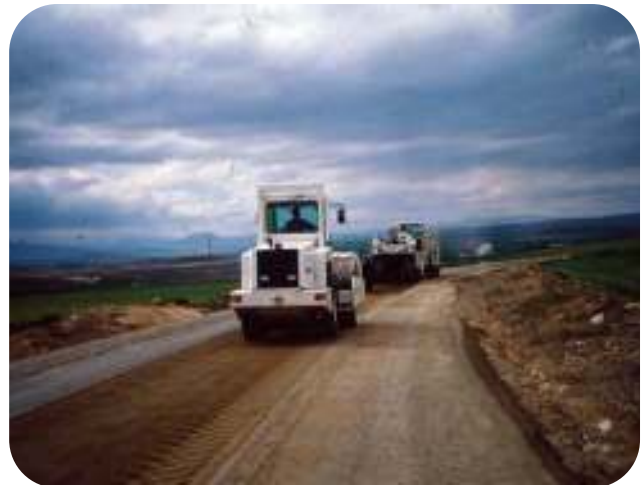
Figura A5.9.- Compactación del material reciclado SG-310. Segovia. 1997
