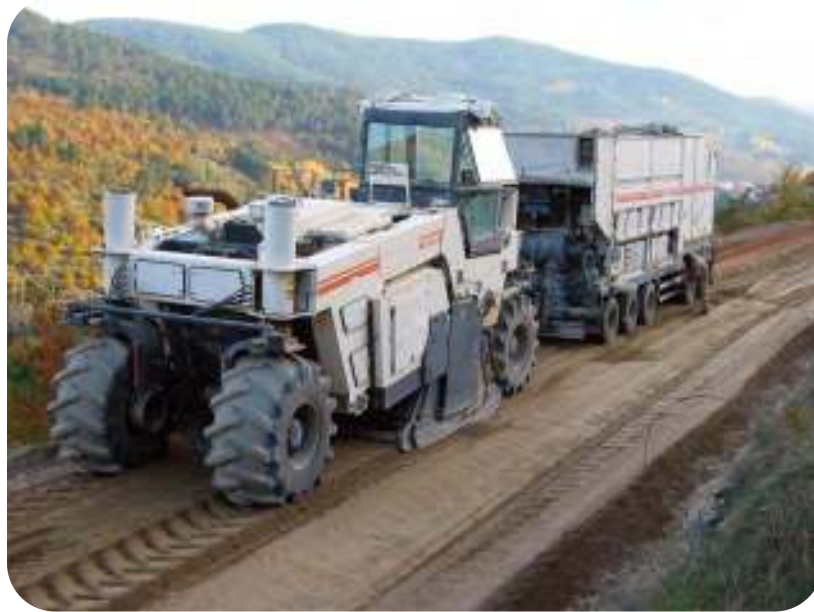
Figura 1.16.- Reciclado in situ con cemento
