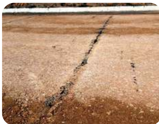
Figura A3.14 y A3.15. – Ejecución de la prefisuración mediante serrado en fresco.
