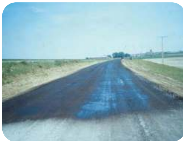
Figuras 8.22 y 8.23.- Curado con emulsión bituminosa
