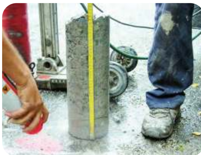
Figura 9.9.- Obtención de testigos de casi 40 cm de material reciclado
