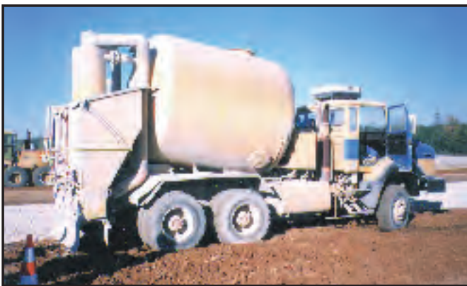
Fig. 8 - Extendido de la cal.
