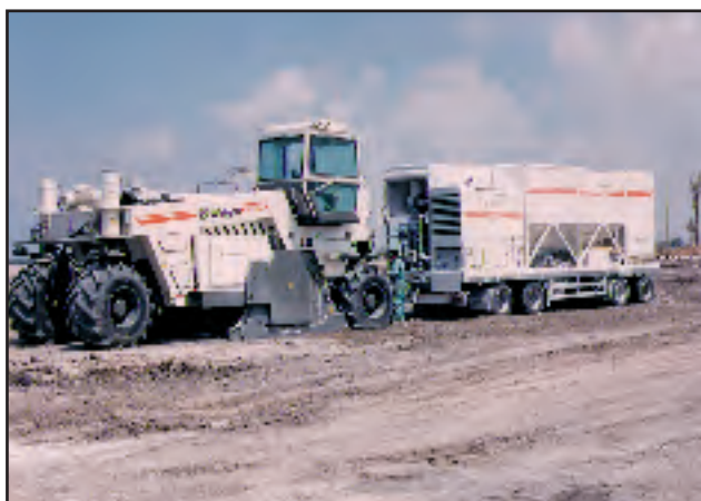
Fig. 16. Tandem mezclador de lechada agua-cal WM400 y estabilizadora WR2500
