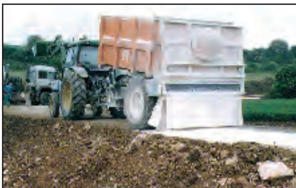
Fig. 12. Extendido de la cal.
