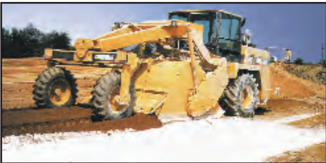
Fig. 9 - Mezclado del suelo y la cal.
