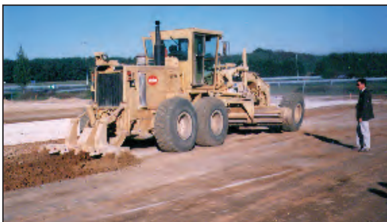
Fig. 10. Escarificación del suelo
